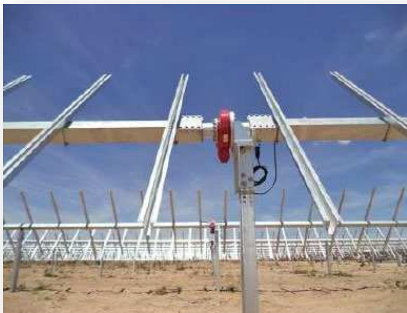
Figura 9- Struttura dell'inseguitore solare monoassiale
