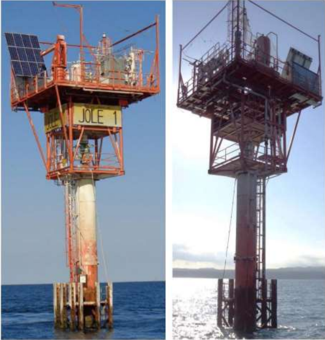
Figura 1-2: Vista della Piattaforma Jole 1 (fonte: Eni)
