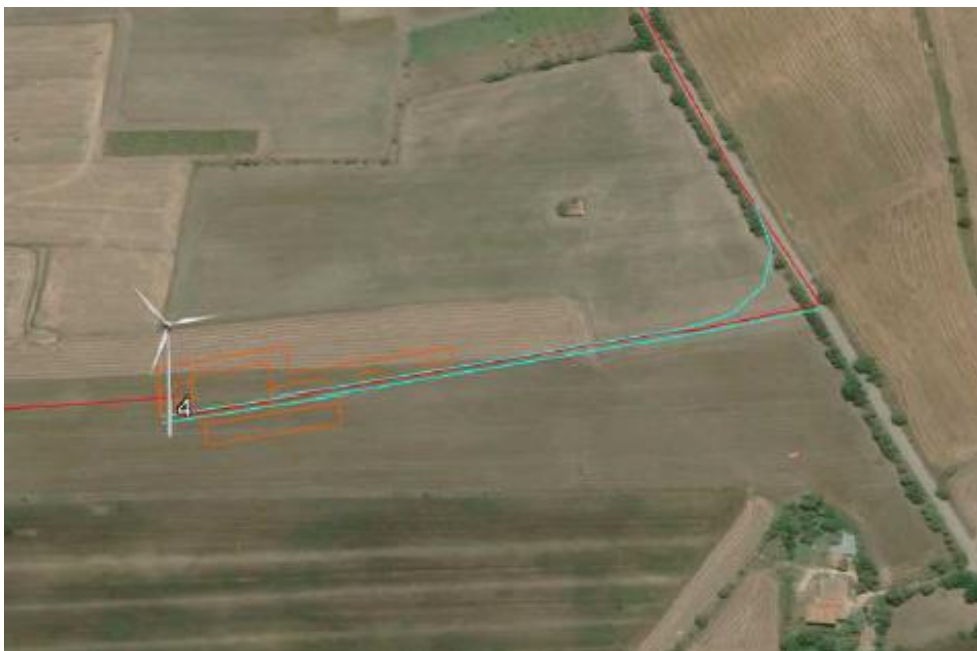
Figura 5 - Sito di installazione WTG 04
