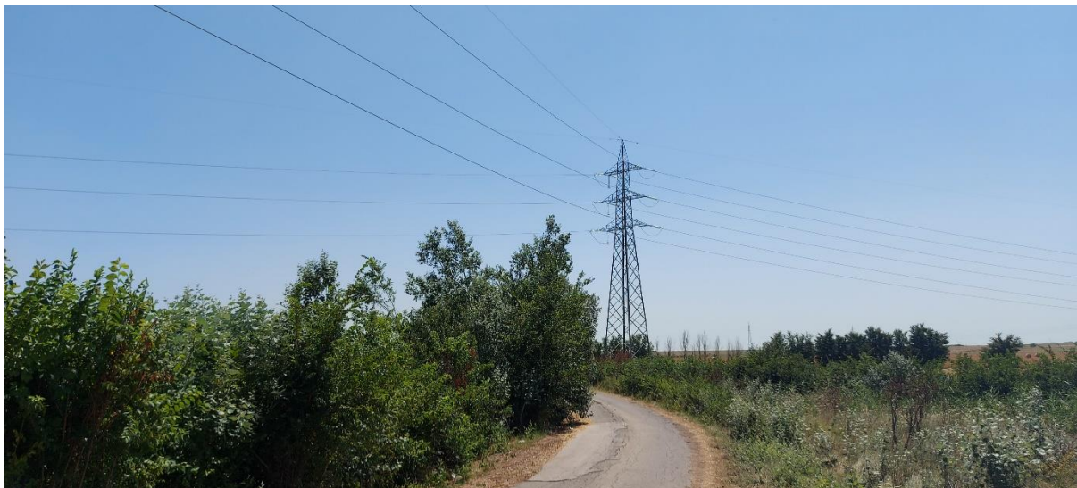
Stato di fatto – Punto di presa fotografica 6
