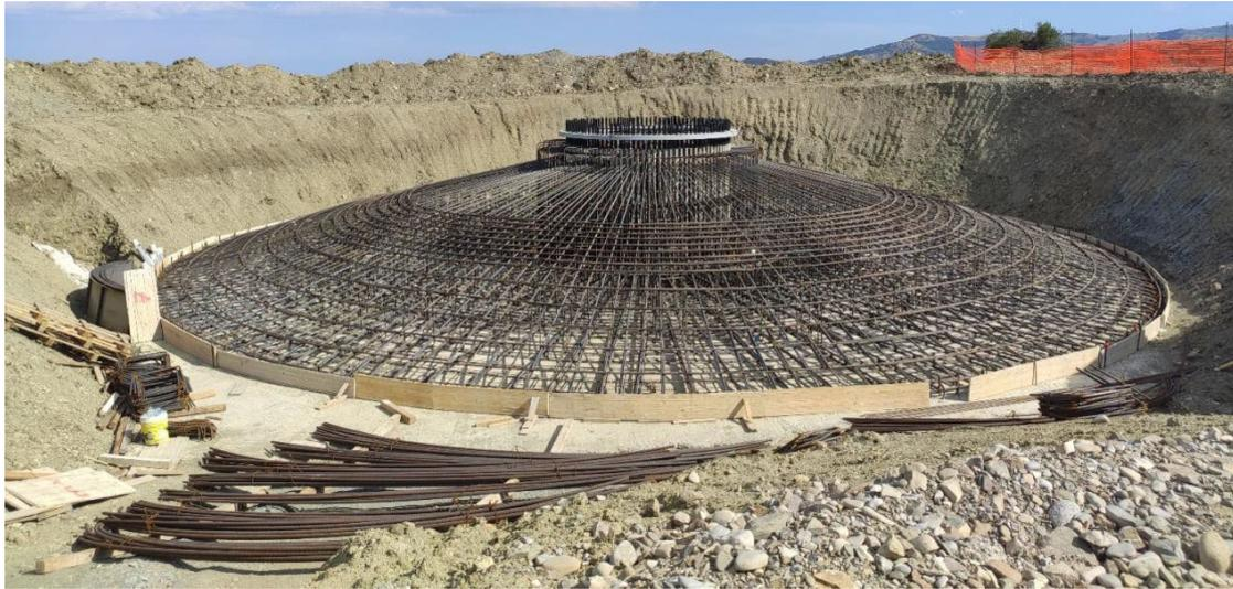
**Figura 3-3: armatura plinto tipo**
