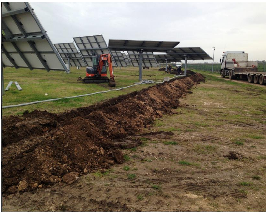
Figura 2: Esempio della fase di scavo trincee
