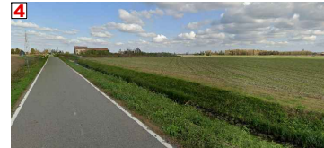
VISTA NORD DI VIA PELOSA
