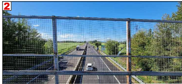
VISTA DELL'A13 DAL PONTE
