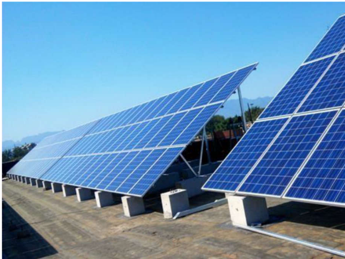
Figura 5 – Esempio di impianto fotovoltaico con fondazioni formate da zavorre costituite da plinti in cemento.
