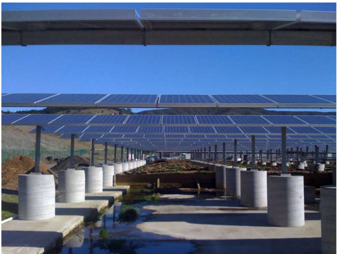
Figura 4 - Esempio di impianto fotovoltaico con fondazioni formate da zavorre costituite da plinti in cemento.
