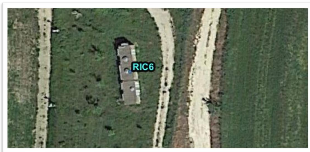
Figura 4 - Inquadramento su ortofoto e da sopralluogo RC6 (C7)
