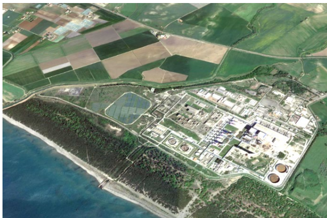
Centrale termoelettrica di Enel
