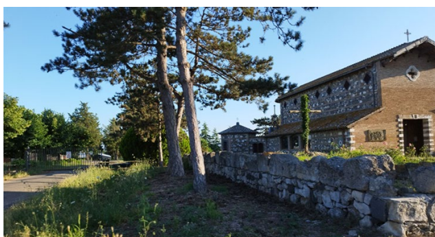
Beni di interesse architettonico
