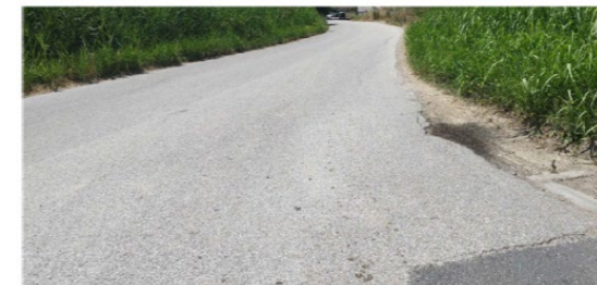
Tipo 2 Viabilità esistente con pavimentazione naturale in discreto stato
