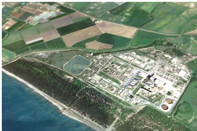
Centrale termoelettrica di Enel
