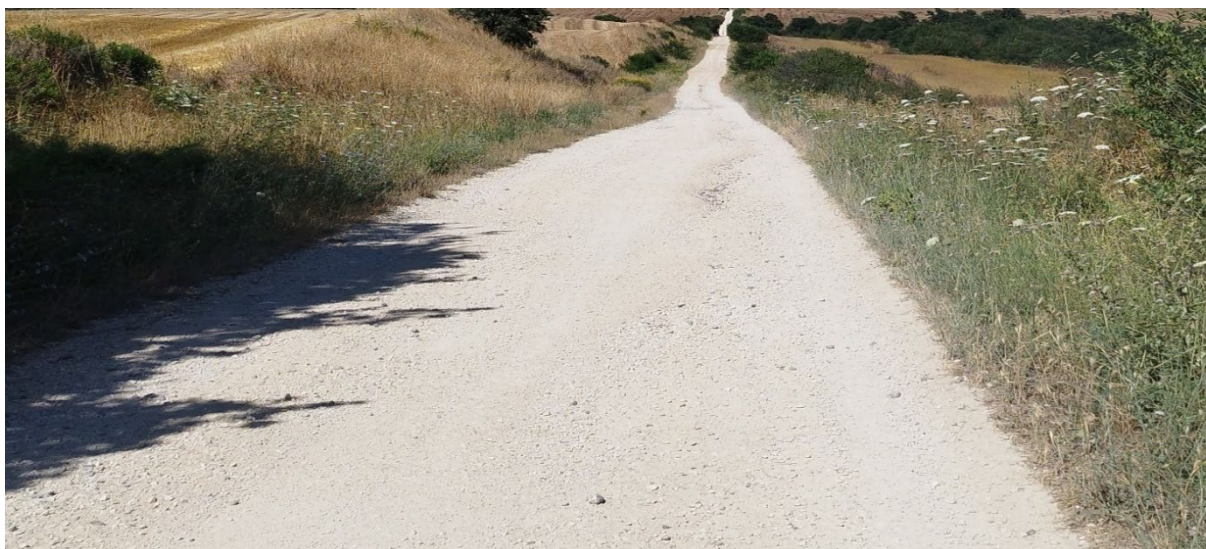
Viabilità esistente con pavimentazione naturale in buono stato
