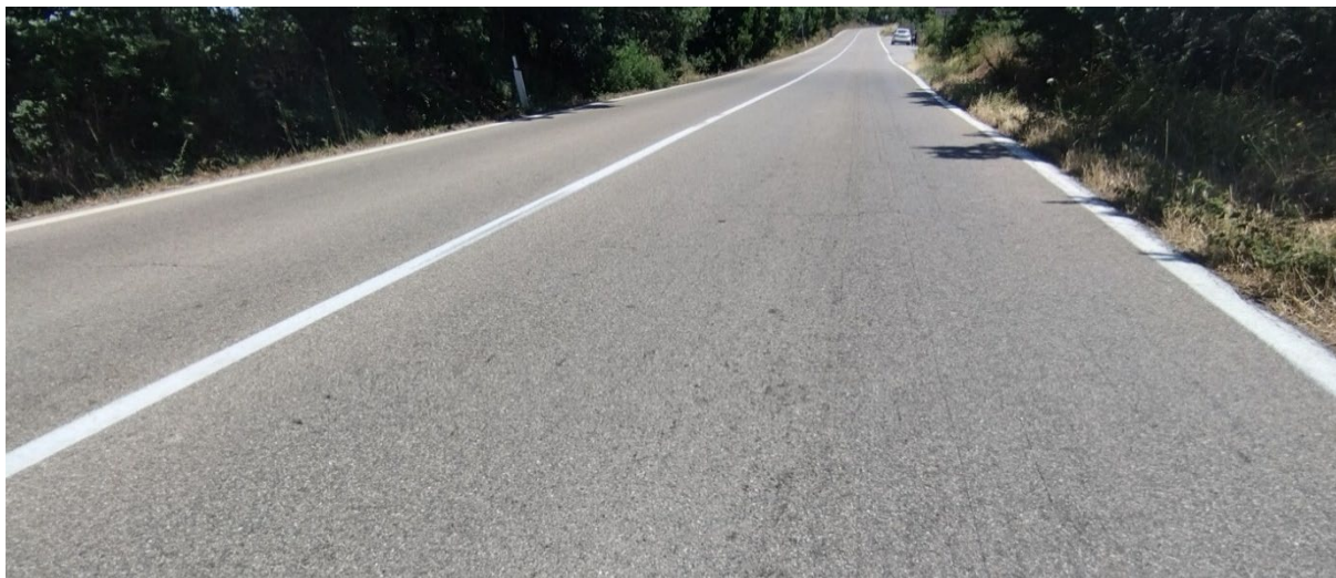
Viabilità in conglomerato bituminoso esistente
