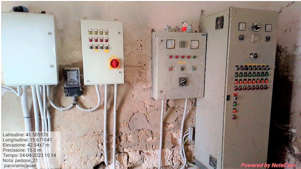
Foto 7.6 – Quadri di comando impianti prese d'acqua pozzi
