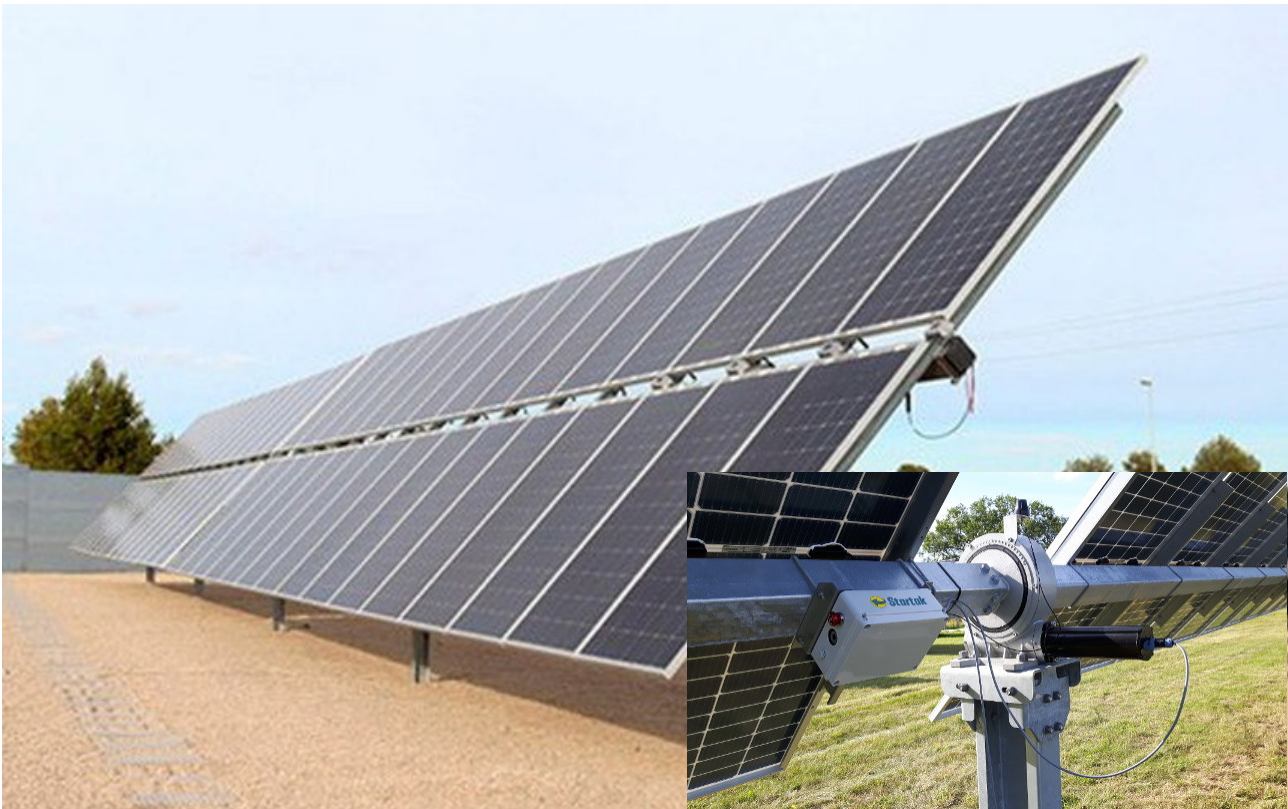
Tracker della PVH con il particolare del motore di rotazione
