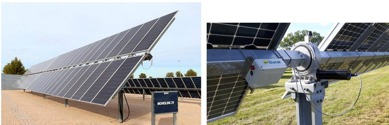
*Tracker della PVH con il particolare del motore di rotazione*
