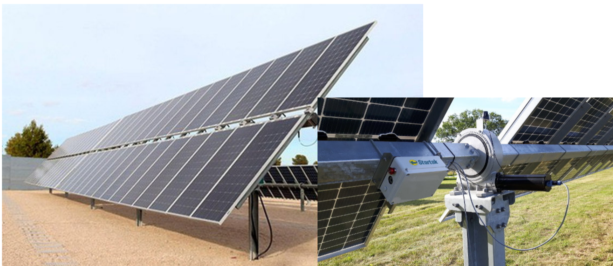
Fig.19- Sistema dei tracker porta moduli
