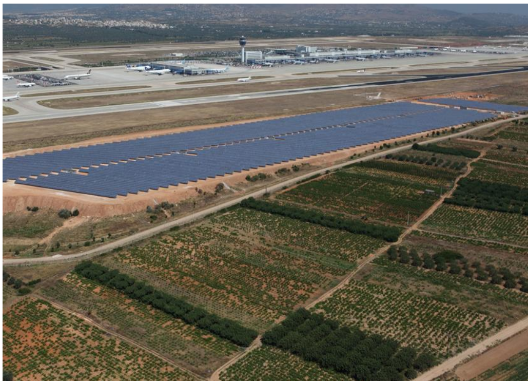
Fig. 5: Aeroporto di Atene con impianto fotovoltaico
