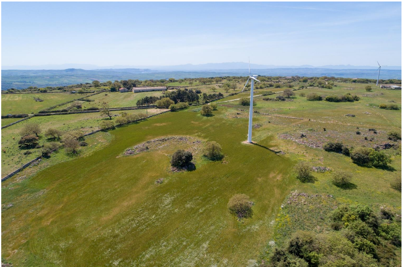
Fig. 3: Foto dello stato di fatto dell'area di progetto coi due aerogeneratori presenti.
