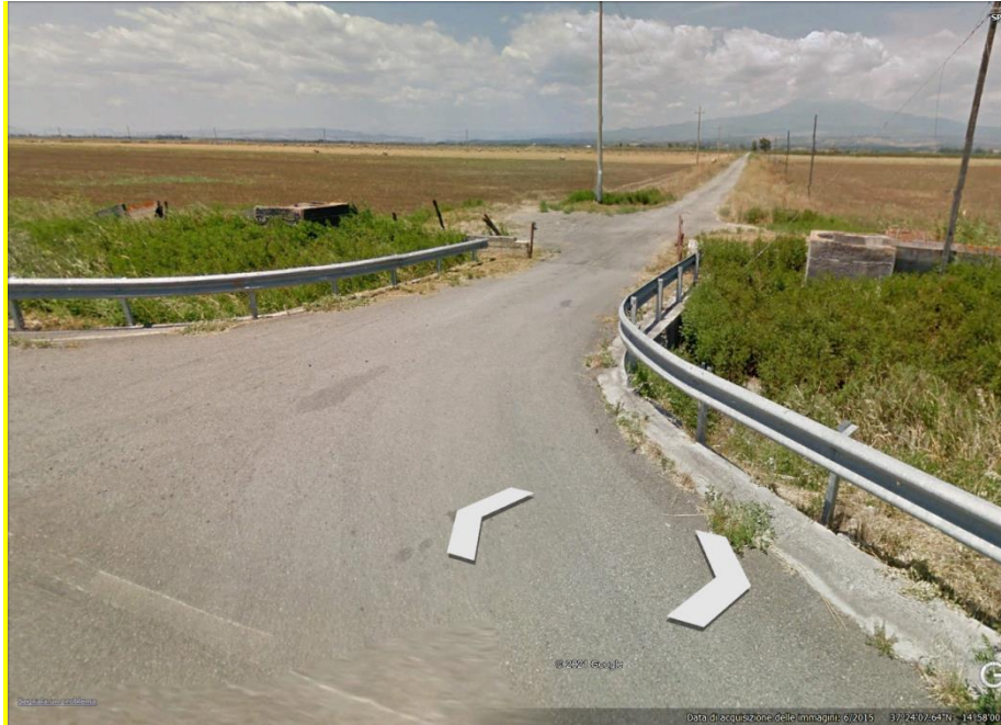
Dettaglio varco di ingresso esistente
