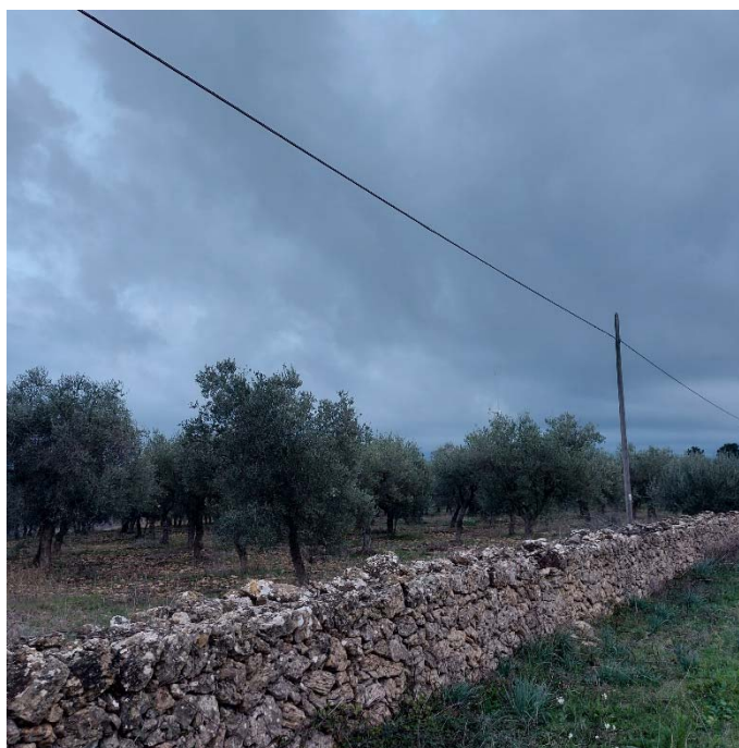
Foto 6 – sopralluogo - muretti a secco
