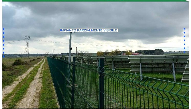
Foto 6 da impianto esistente ID: F/COM/F784/105_09_98_09
