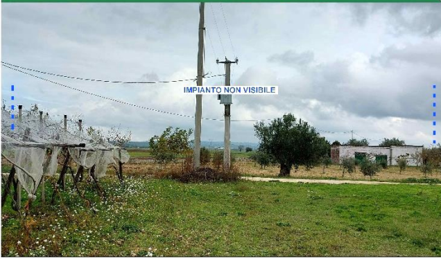
Foto 3 da impianto esistente ID: F/COM/F784/107_08_39_08_86_08
