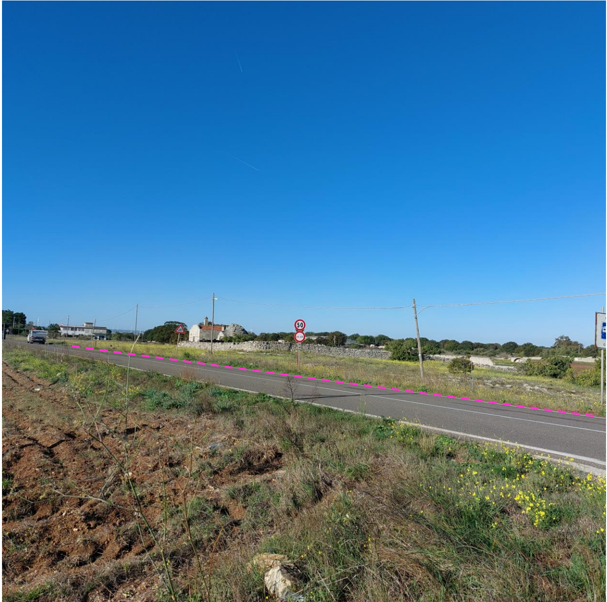
Figura 3. 2 Vista strada punto 1
