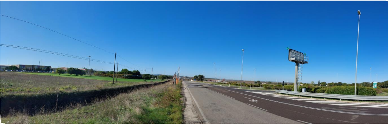
Figura 3. 3 Panoramica strada punto 2
