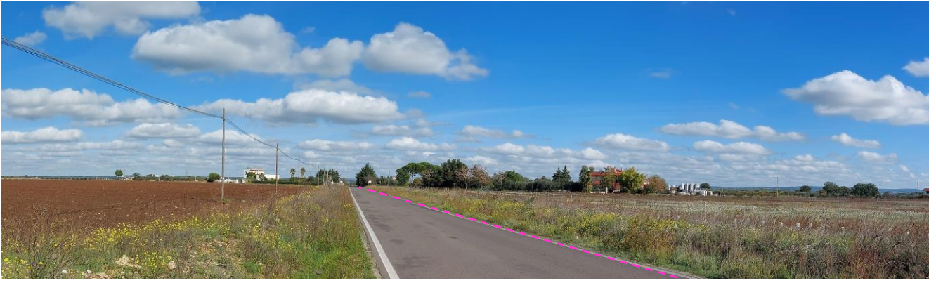
Figura 3. 5 Panoramica strada punto 3
