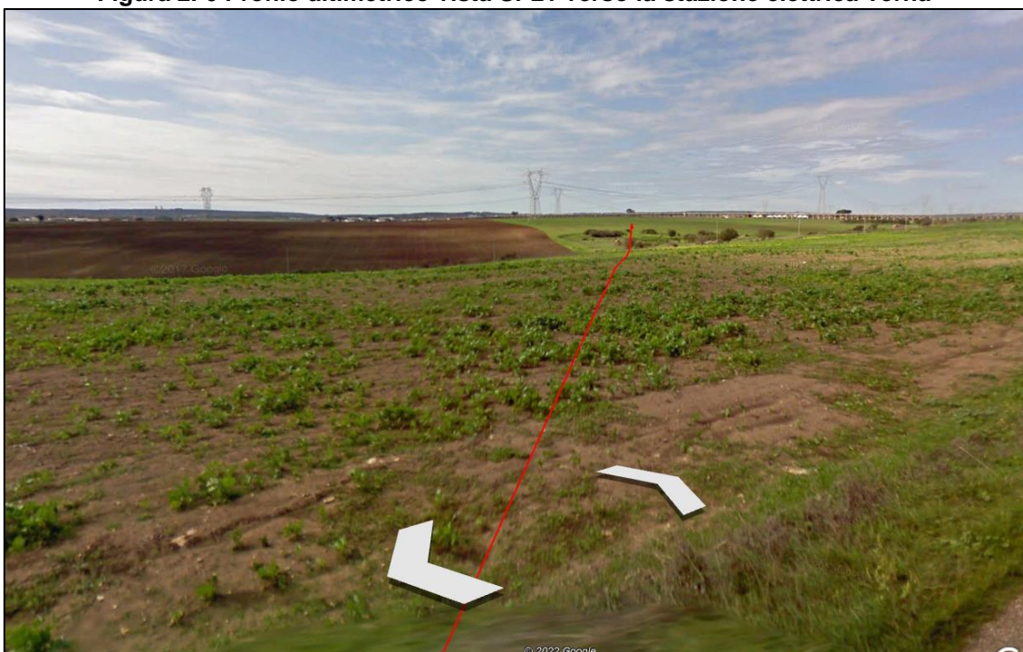
Figura 2. 7 Vista dalla SP21 in direzione della stazione elettrica Terna
