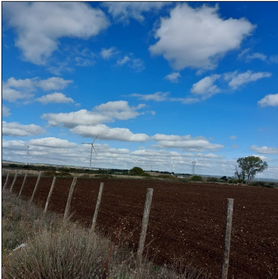
Figura 1. 6 Vista dal terreno della stazione utente
