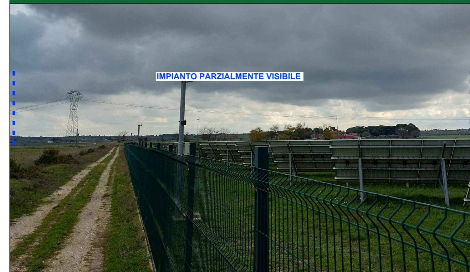
Foto 6 da impianto esistente ID: F/COM/F784/105_09, 98_09
