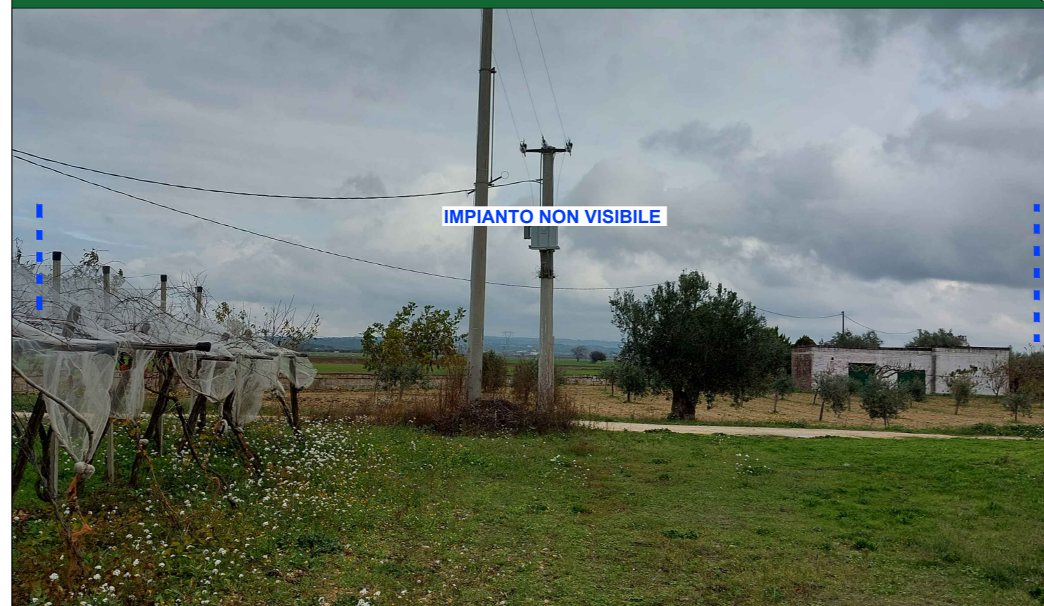
Foto 3 da impianto esistente ID: F/COM/F784/107_08, 39_08, 86_08
