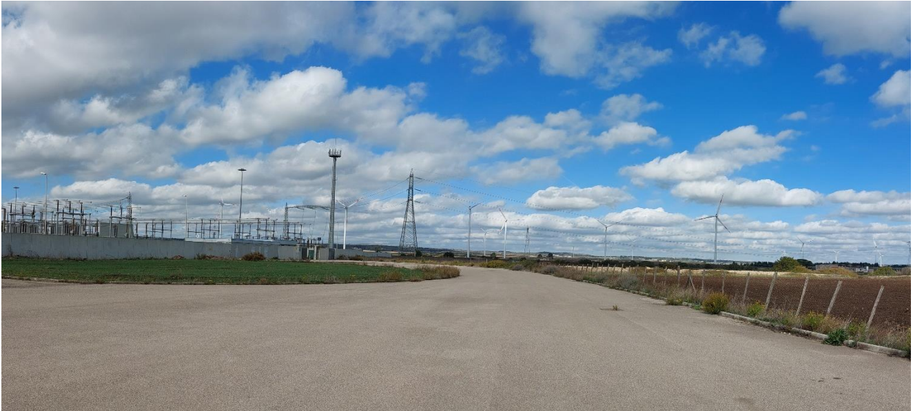
Figura 18 - Area Stazione RTN e Stazione utente – Ante operam
