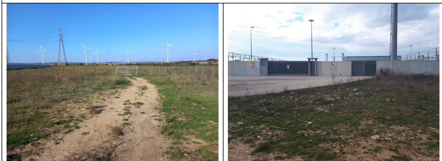
Stazione Elettrica TERNA 'Castellaneta', U.R. 22
