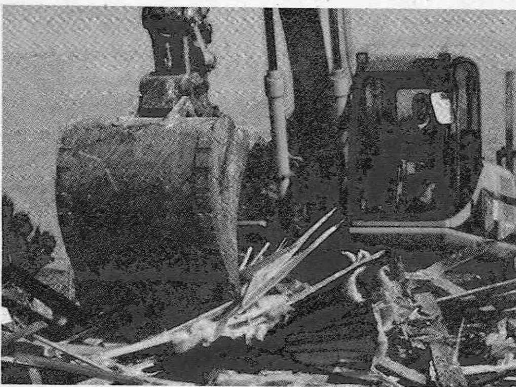
Una ruspa in azione nell'opera di demolizione di una casa abusiva
