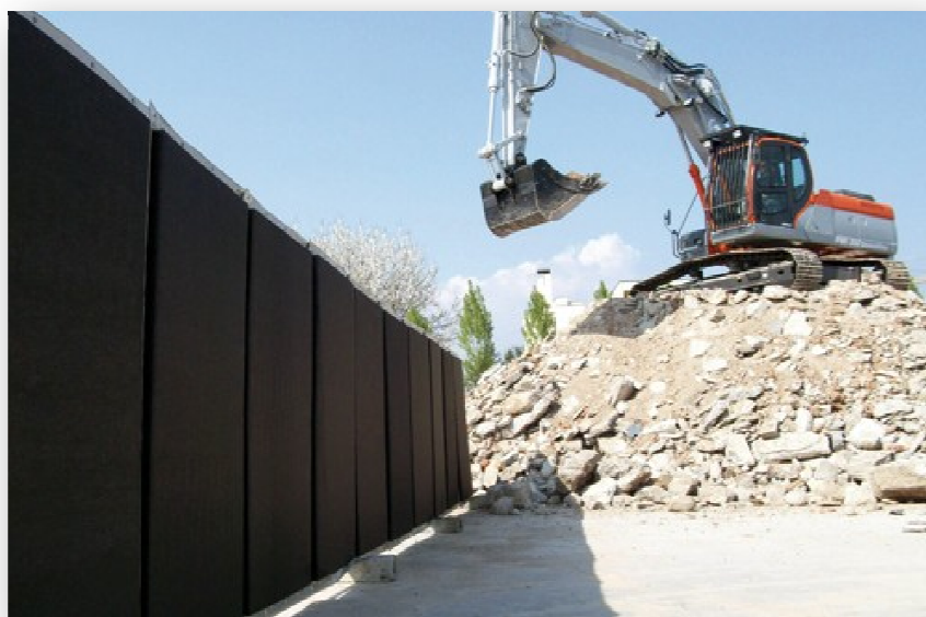
Figura 16 Esempio di barriera antirumore mobile per cantiere
