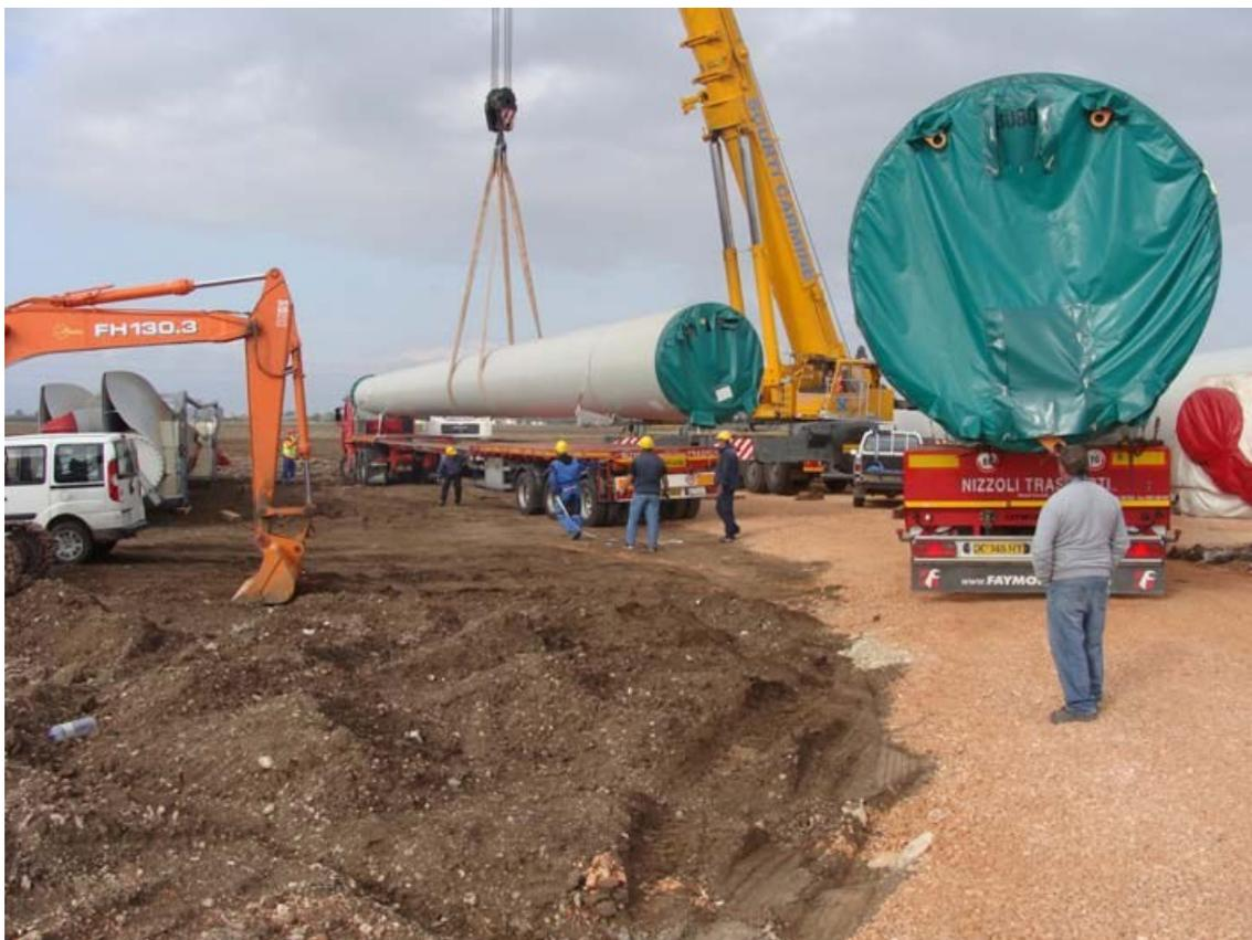
**Figura 6:** elementi torre smontata da trasportare
