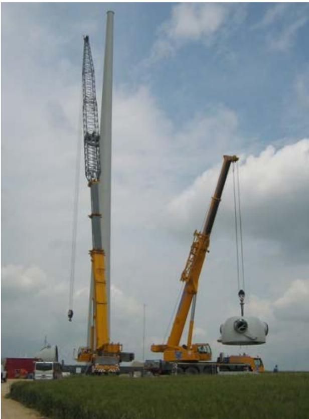
**Figura 3:** smontaggio navicella
