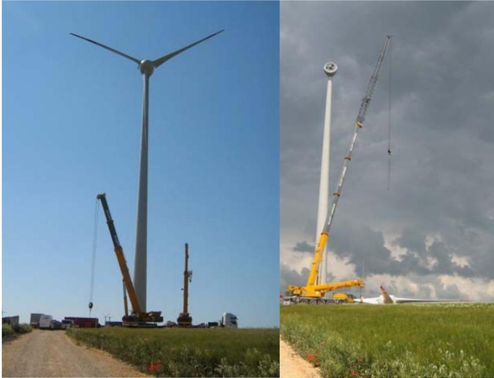
**Figura 2:** rimozione eliche e mozzo
