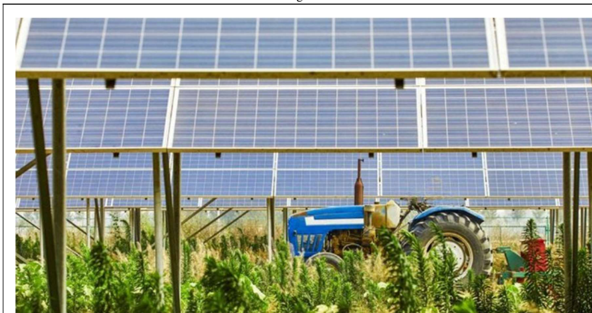
Foto laterale fra i pannelli esemplificativa di un Parco Agro-Fotovoltaico
