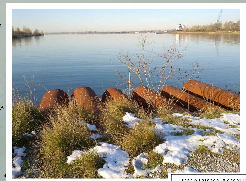
SCARICO ACQUE CASSA DI COLMATA
