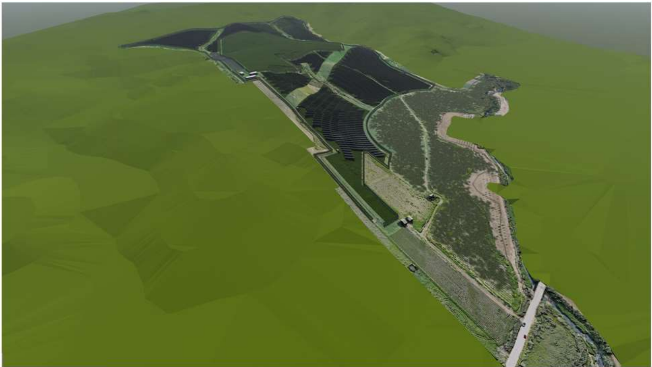
Area 1 Vista Nord
