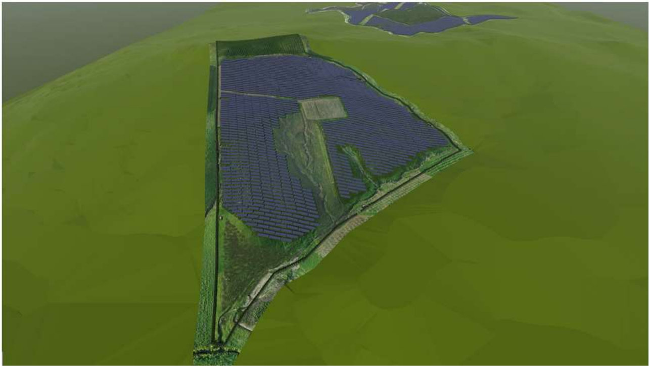
Area 2 Vista Sud – In alto a destra l’Area 1
