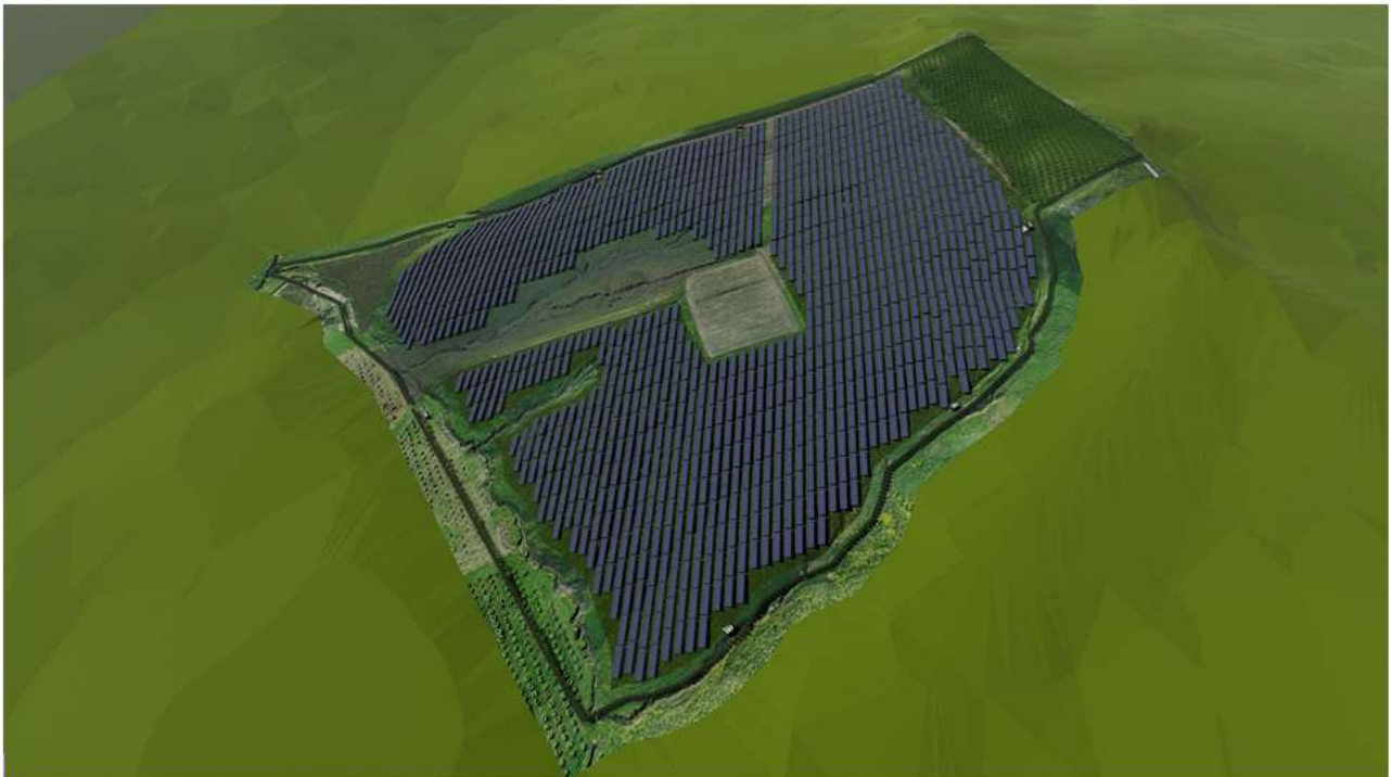
Area 2 Vista Est
