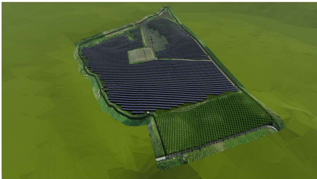
Area 2 Vista Nord
