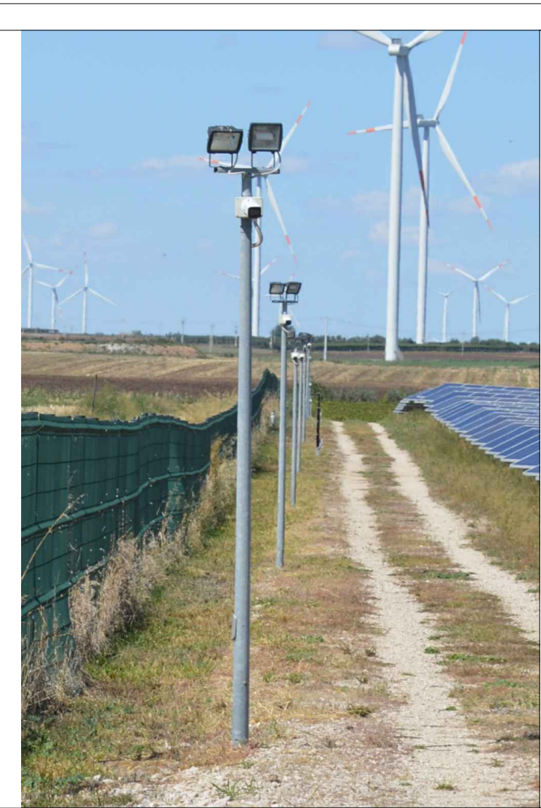
PARTICOLARE PALO ILLUMINAZIONE E VIDEOSORVEGLIANZA SCALA 1:50
