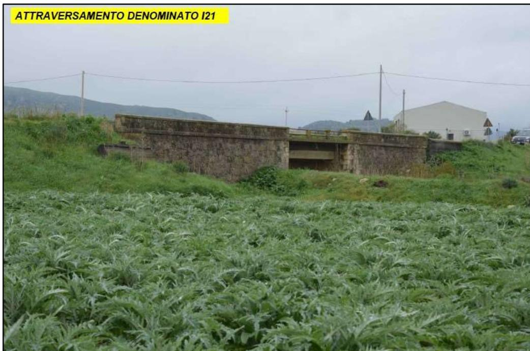
La foto mostra il ponte in pietra che attraversa il corso d'acqua. Il cavidotto sarà realizzato secondo la tecnologia T.O.C. (trivellazione orizzontale controllata).
