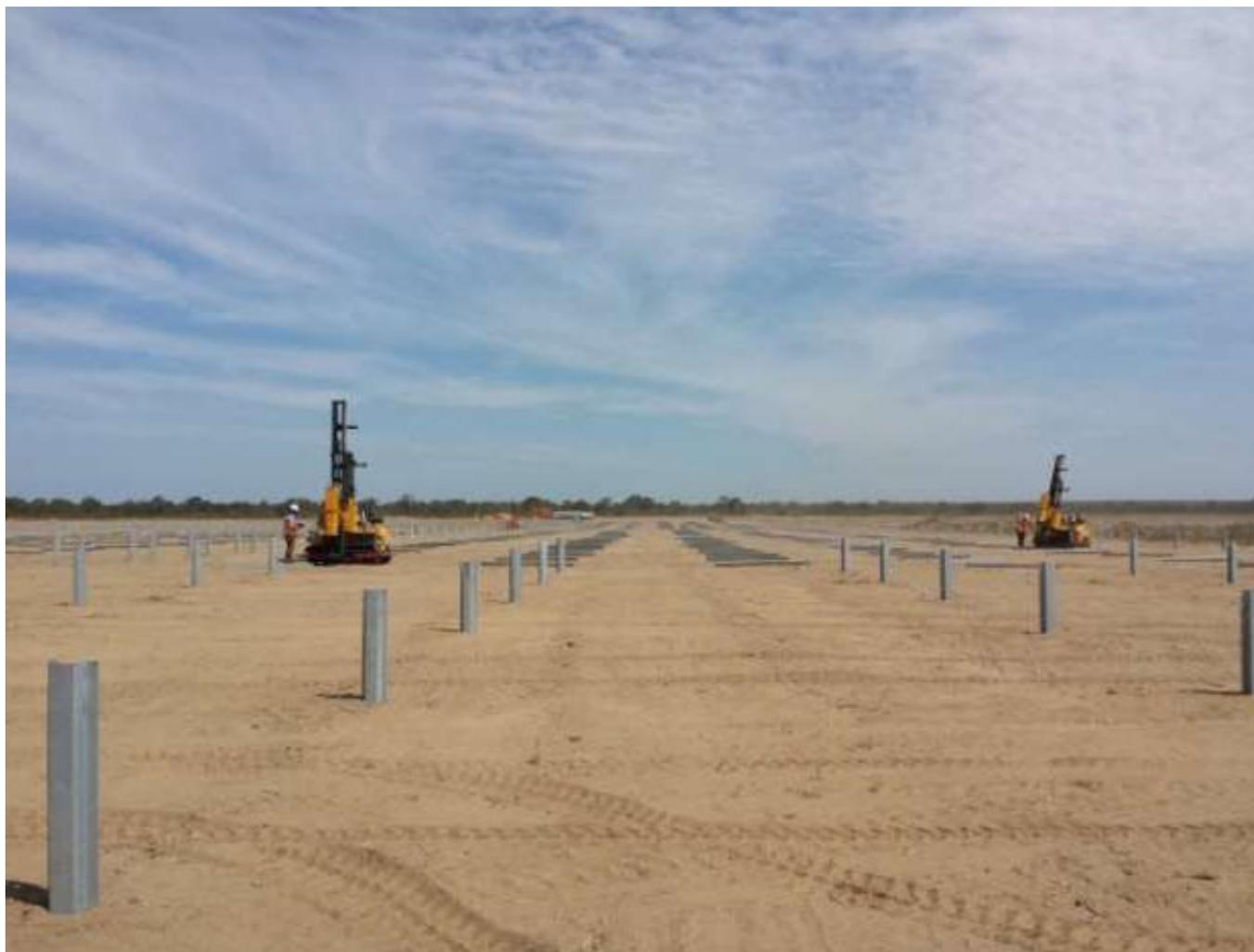
*Figura 26 - Esempio di disposizione dei pali di fondazione delle strutture*
