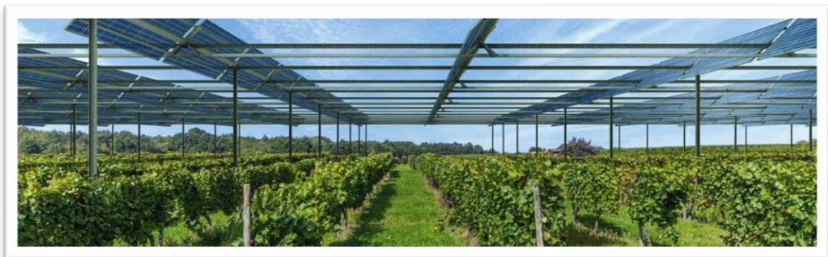
Figura 86. Esempio di Impianto “Agrivoltaico”.
