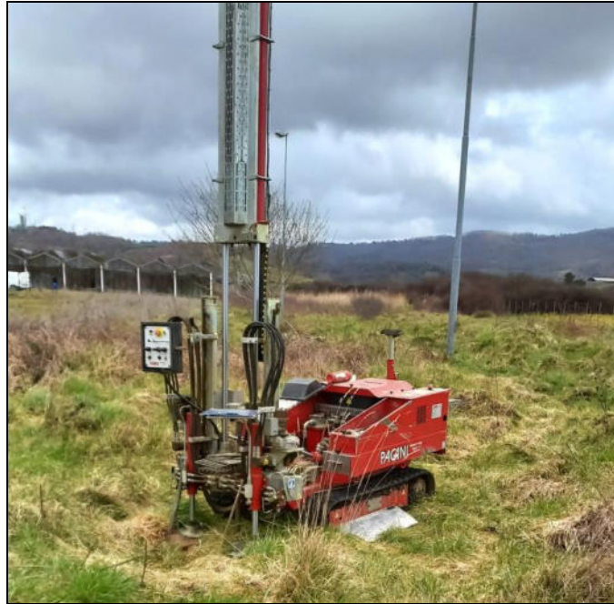
Foto 3: Esecuzione prova penetrometrica DPSH3
