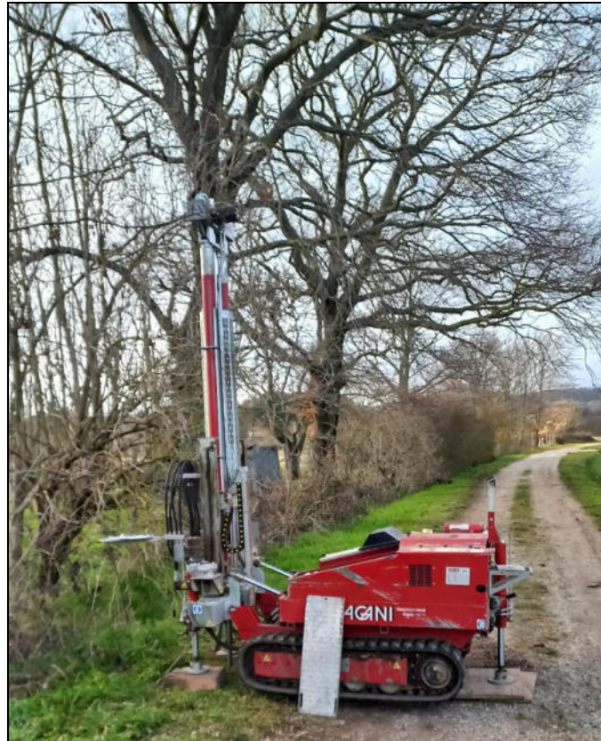
Foto 4: Esecuzione prova penetrometrica DPSH4
