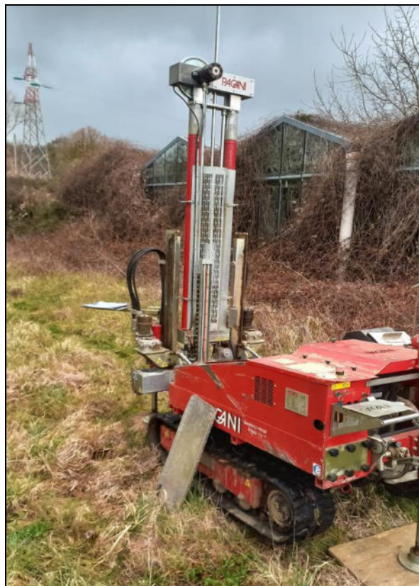
Foto 2: Esecuzione prova penetrometrica DPSH2.
