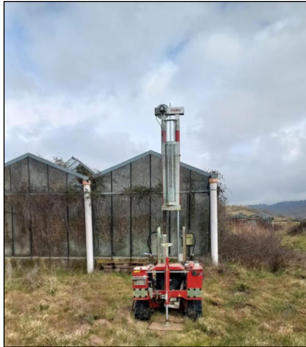
Foto 1: Esecuzione prova penetrometrica DPSH1
