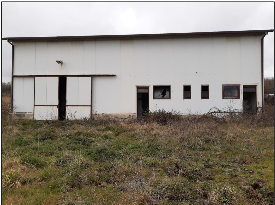
Figura 2.1.d Particolare esterno edificio magazzino in disuso presenti all'interno del polo produttivo agro-energetico
