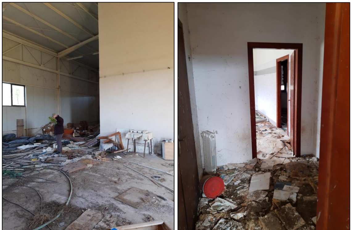
Figura 2.1.f Particolare interno degli edifici in disuso presenti all'interno del polo produttivo agro-energetico
