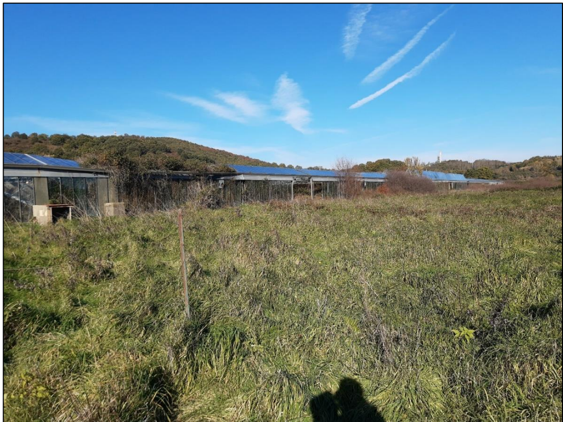
Figura 2.1.j Particolare esterno delle serre in disuso insistenti all'interno del polo produttivo agro-energetico (punto di vista da Sud verso Nord lato orientale)
