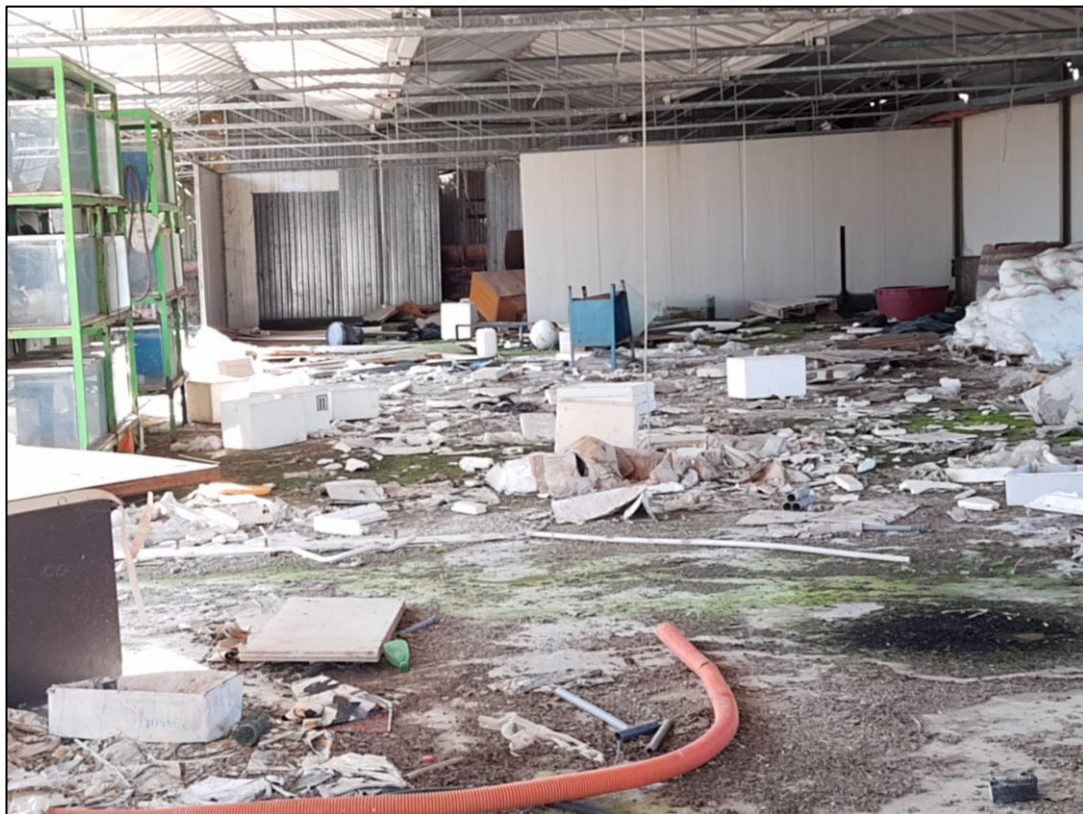
Figura 2.1.n Particolare interno delle serre in disuso insistenti all'interno del polo produttivo agro-energetico
