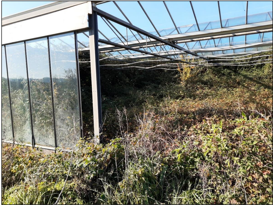
Figura 2.1.i Particolare esterno delle serre in disuso insistenti all'interno del polo produttivo agro-energetico
