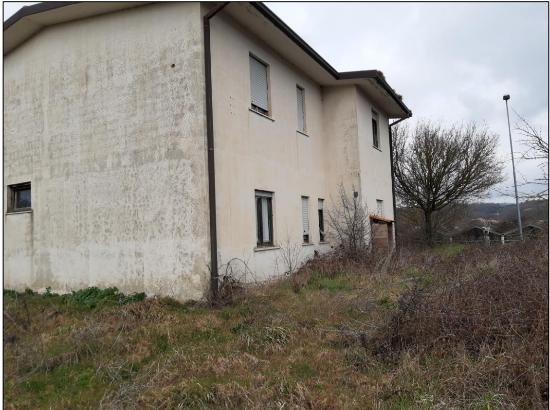
Figura 2.1.c Particolare esterno edificio abitativo (Guardiana) in disuso presente all'interno del polo produttivo agro-energetico
