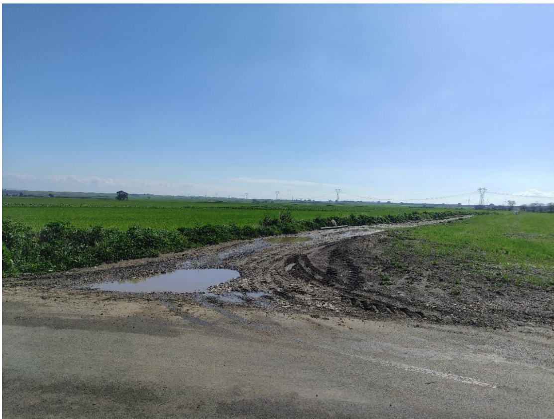
Foto 18a - Punto di presa n° 18 Stato di Fatto – Sottostazione Utente 01
