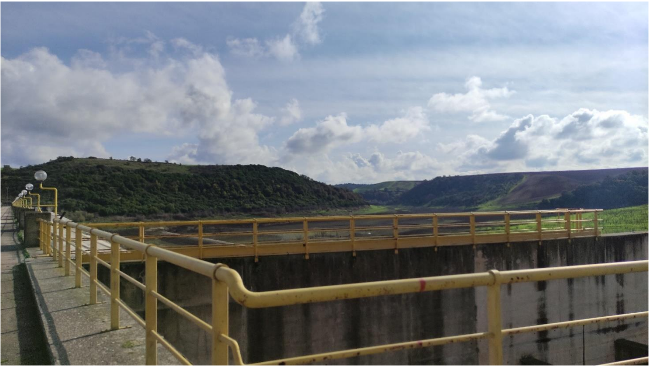
Foto 7a – Punto di Presa n° 7 Stato di Fatto – Invaso Toppo di Francia (o del Lampeggiano)
