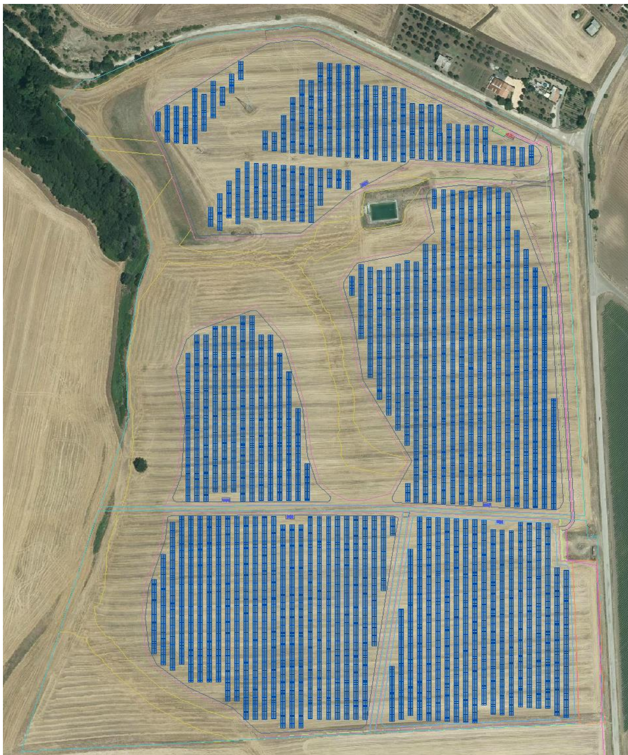
Figura 3.7. – Dettaglio Impianto Agrovoltaiico su base Ortofoto.
