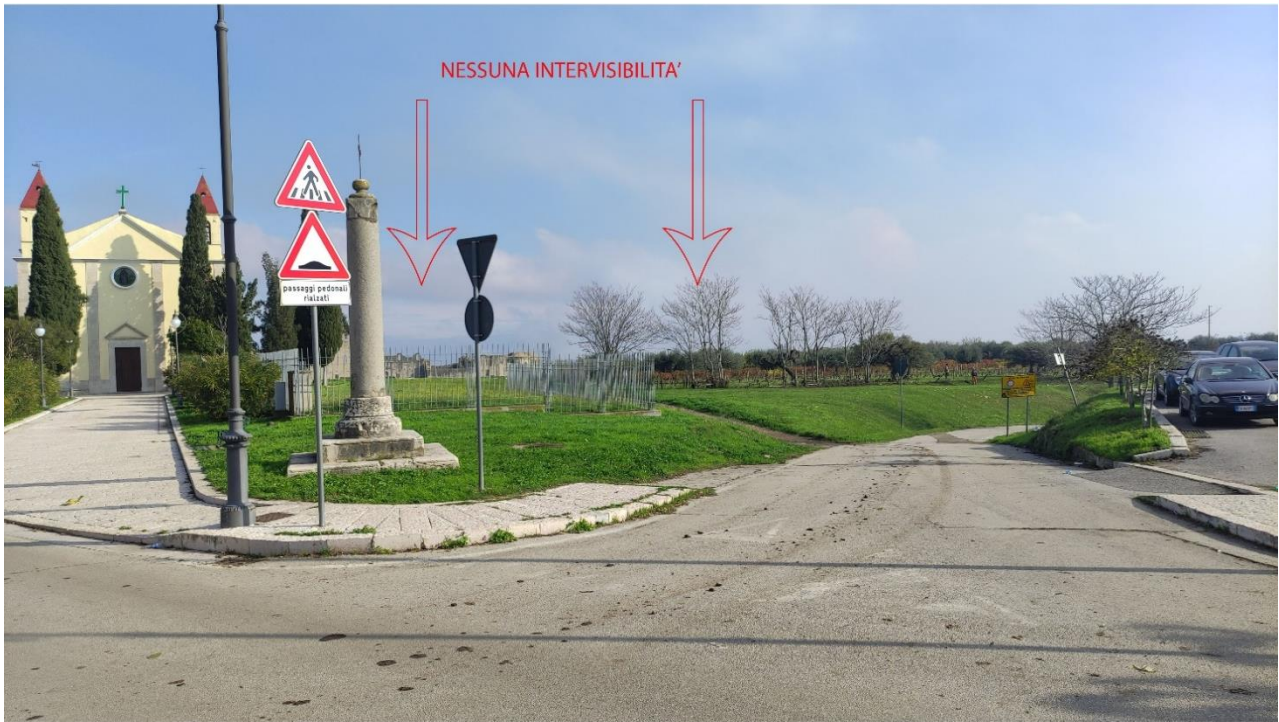
Foto 10b – Punto di Presa n° 10 Stato di Progetto - Nei pressi del Centro Abitato di Venosa
