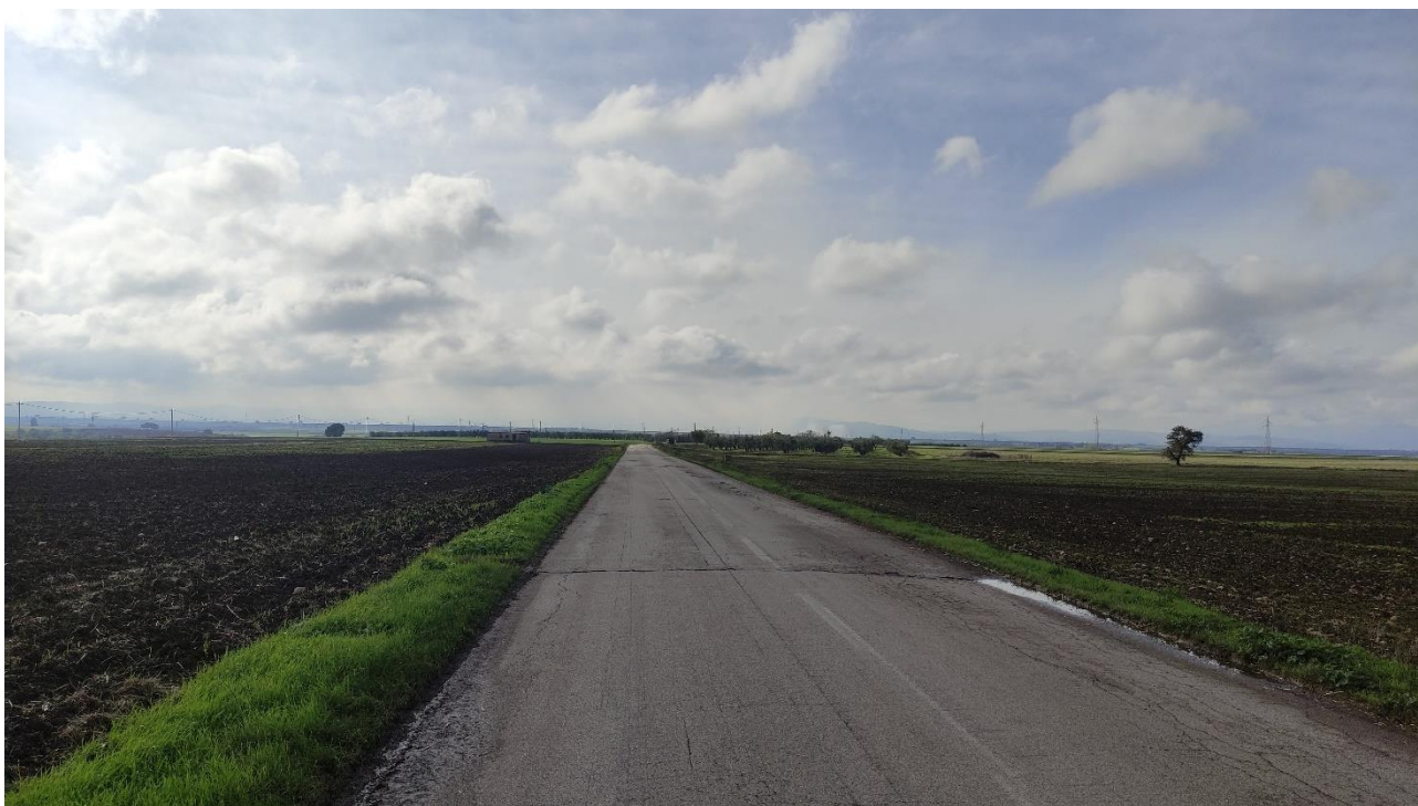
Foto 4a – Punto di Presa n° 4 Stato di Fatto - Strada Provinciale n. 18 "Ofantina"
