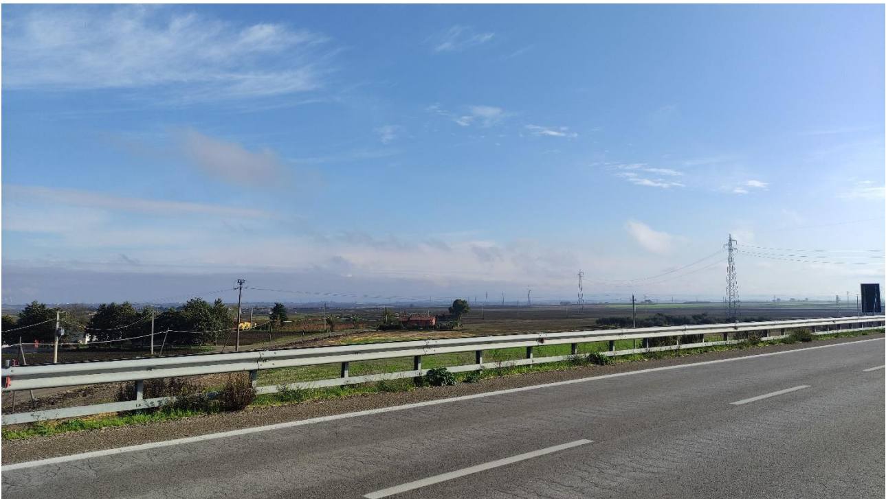
Foto 2a – Punto di Presa n° 2 Stato di Fatto – Strada Statale n. 655 "Bradonica"
