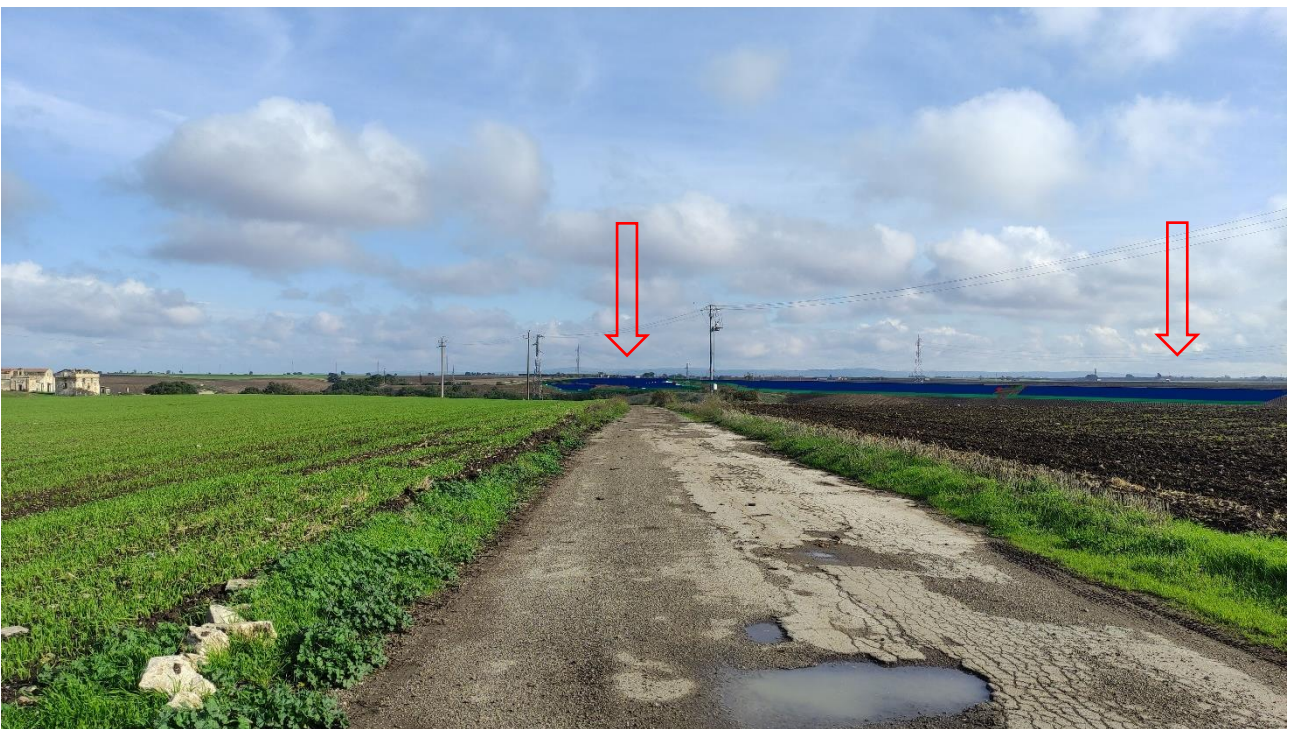
Foto 1b – Punto di Presa n° 1 Stato di Progetto - Strada Provinciale n. 135 "Boreana"
