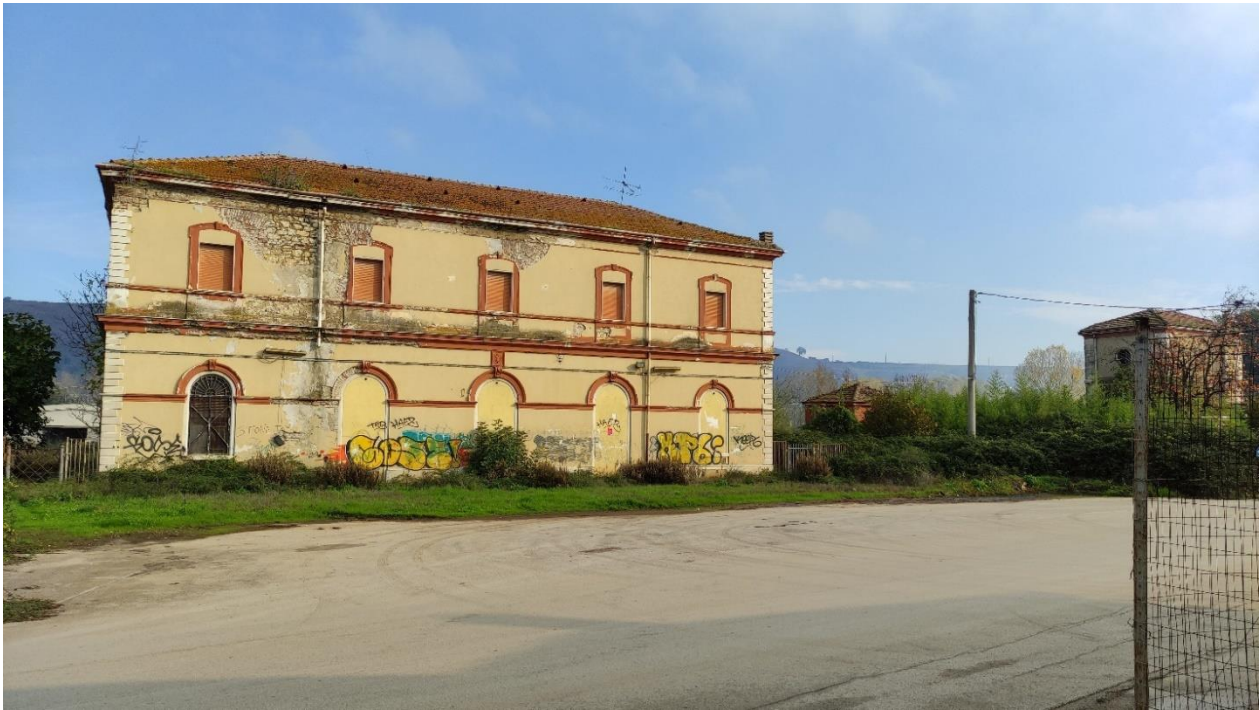
Foto 11a – Punto di Presa n° 11 Stato di Fatto – Bene Monumentale "Stazione Ferroviaria Venosa – Maschito"
