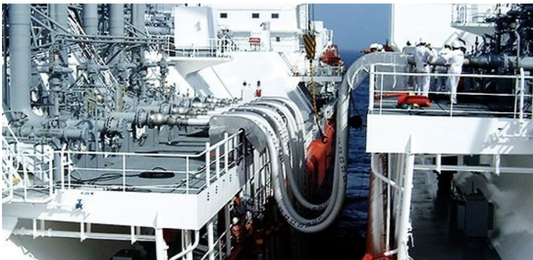
Figura 39 – Tipico collegamento STS per trasferimento GNL
