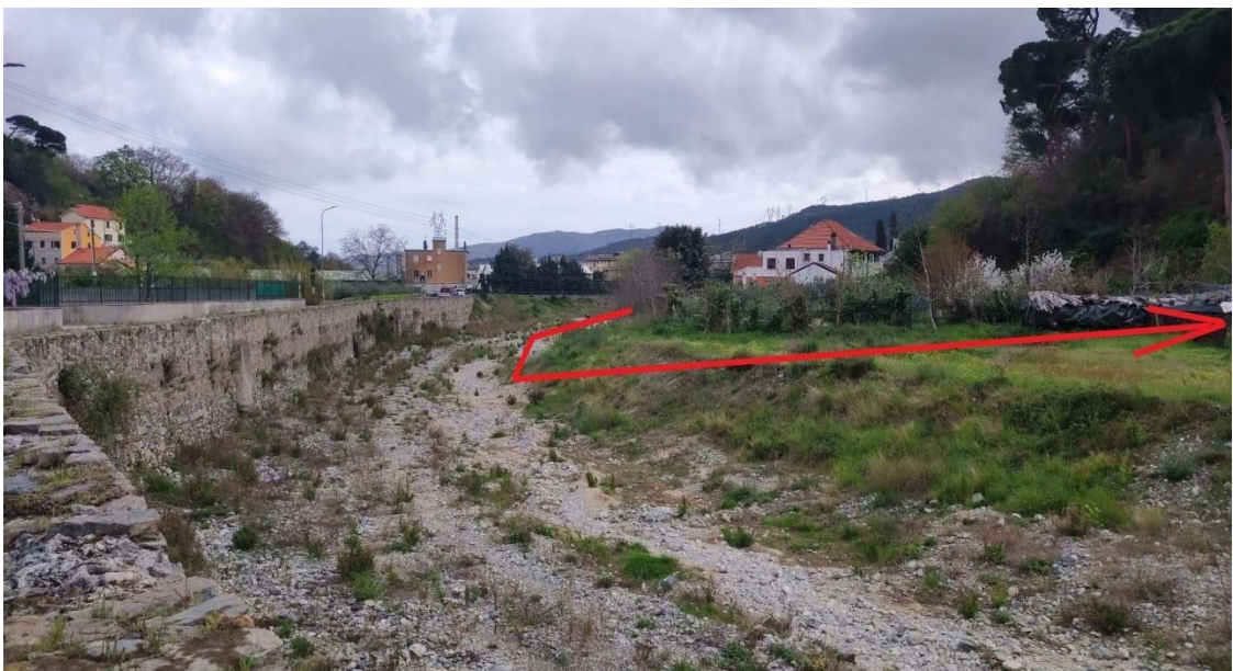
Foto n. 2 Tratto terminale di percorrenza del Torrente Quazzola
