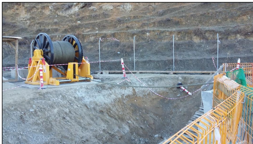
Figura 4.25: Argano con fune d'acciaio per il tiro della condotta nel MT
