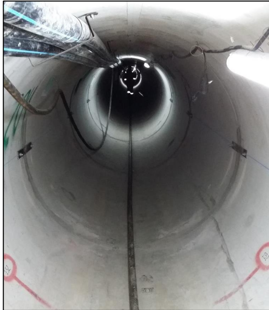
Figura 4.26: Tunnel pronto per l’inserimento della condotta. La fune d’acciaio collegata all’argano è stesa sul fondo del MT
