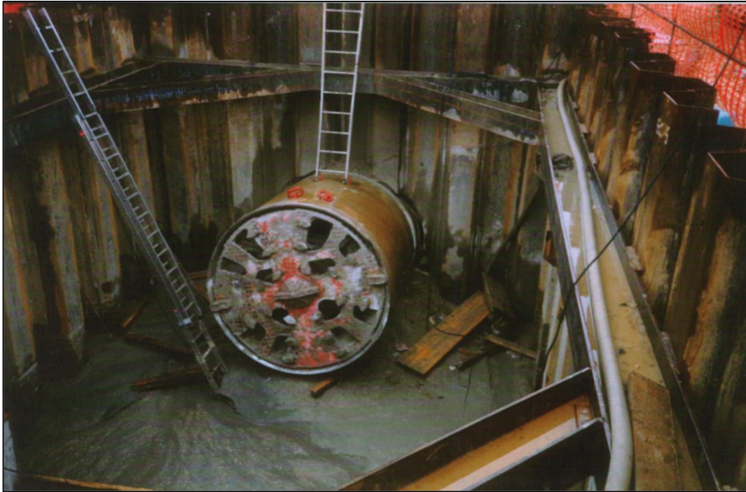
Figura 4.24: Pozzo di recupero della fresa di un Microtunnel (MT)
