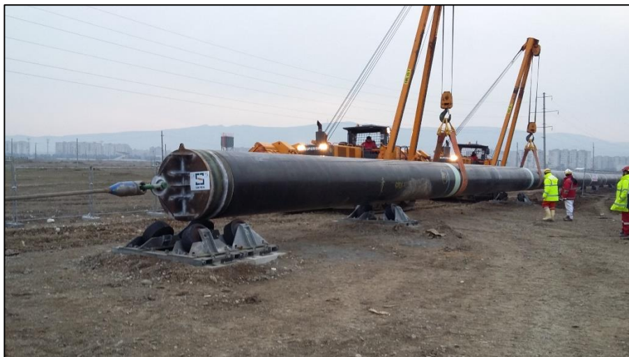
Figura 4.29: Installazione della stringa di condotta nel microtunnel
