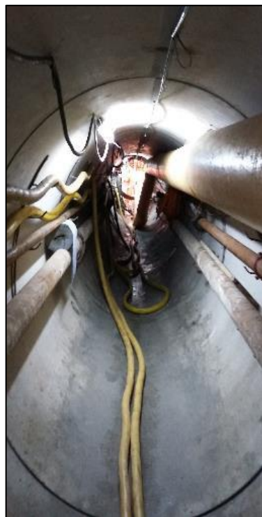
Figura 4.23: Interno di un Microtunnel (MT) durante lo scavo
