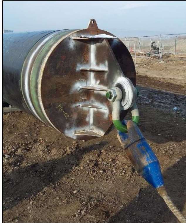
Figura 4.28: Testa di tiro saldata alla stringa di condotta da inserire nel MT e collegamento con la fune d'acciaio collegata all'argano
