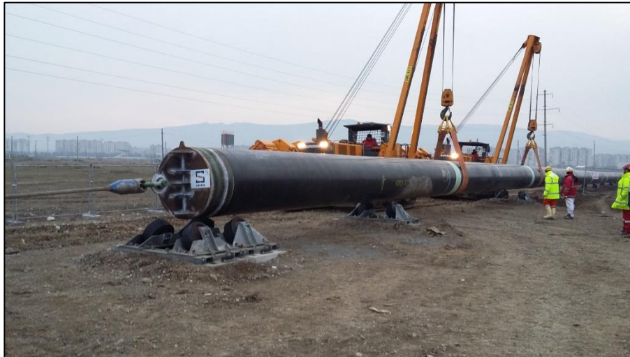
Figura 2.30: Installazione della stringa di condotta nel microtunnel
