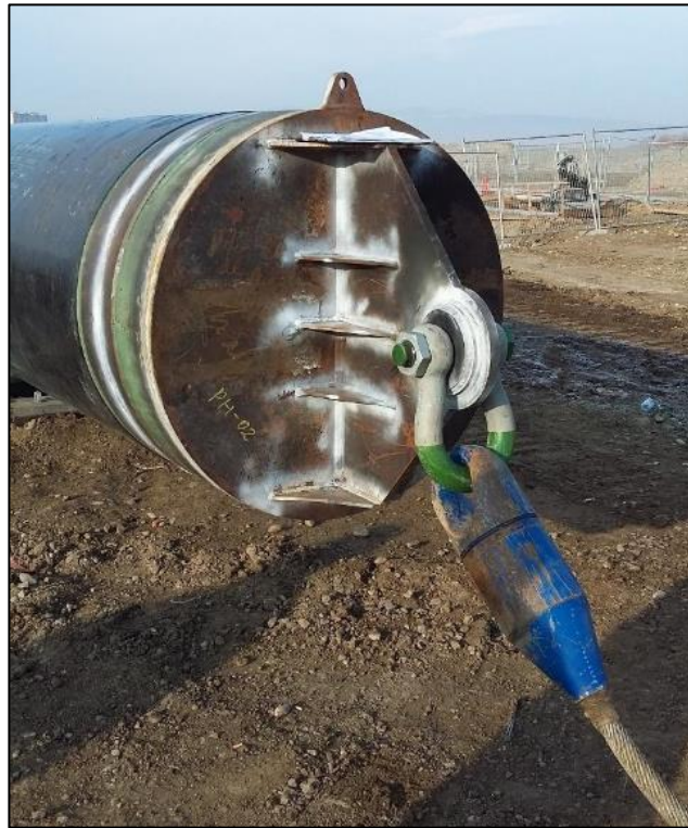
Figura 2.29: Testa di tiro saldata alla stringa di condotta da inserire nel MT e collegamento con la fune d'acciaio collegata all'argano
