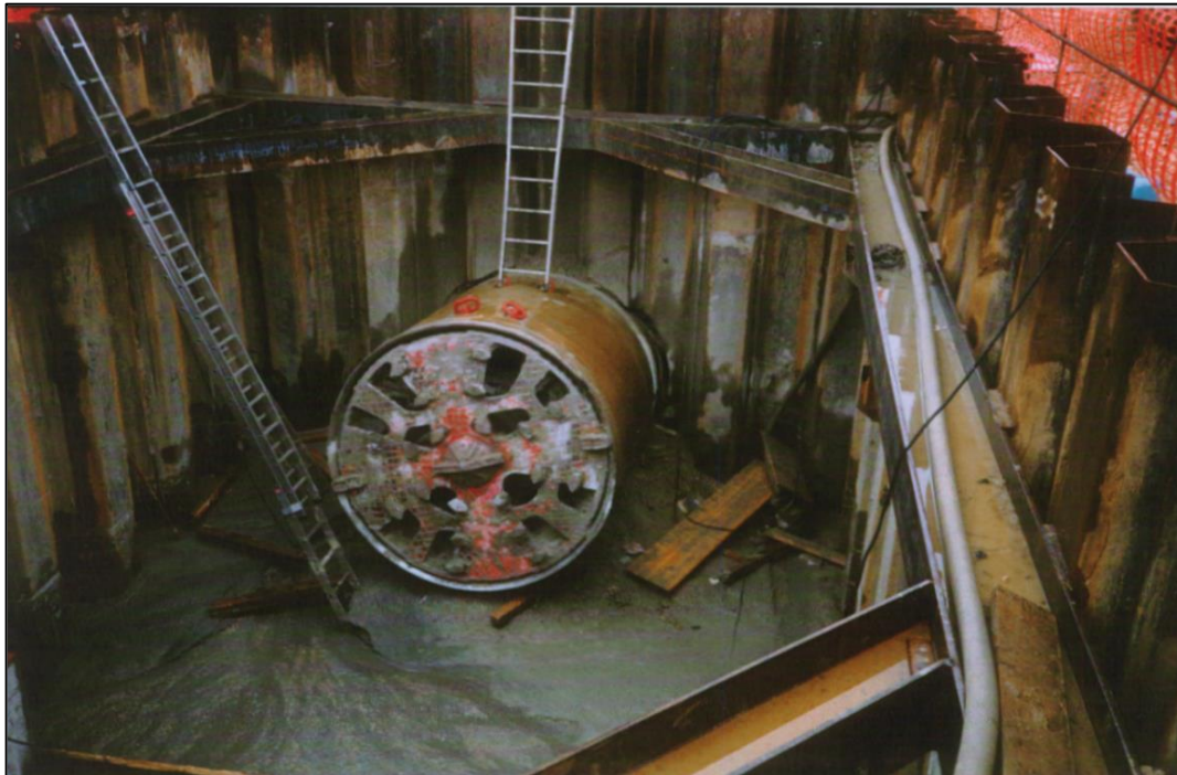
Figura 2.25: Pozzo di recupero della fresa di un Microtunnel (MT)
