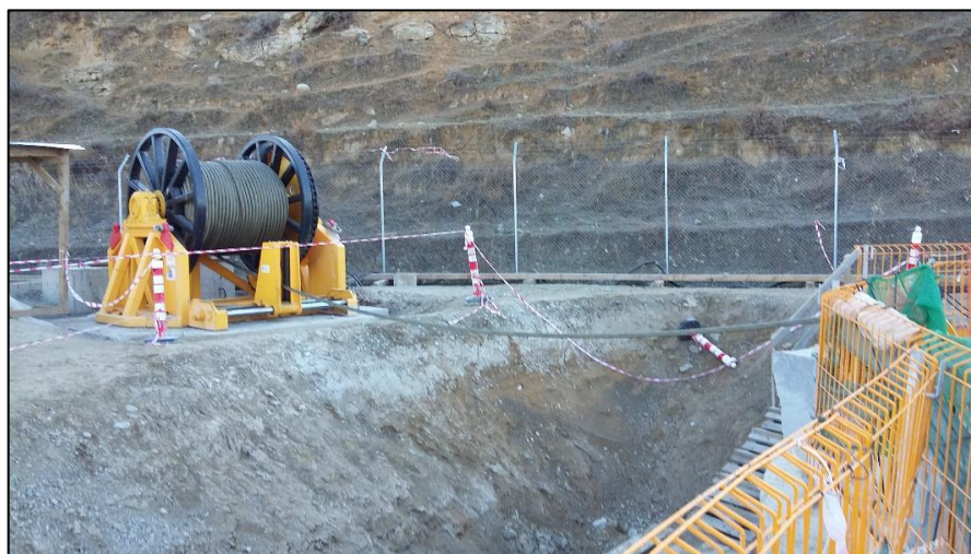
Figura 2.26: Argano con fune d'acciaio per il tiro della condotta nel MT
