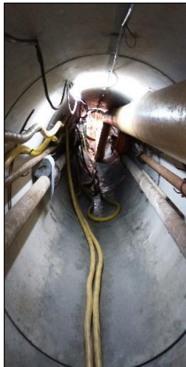
Figura 2.24: Interno di un Microtunnel (MT) durante lo scavo
