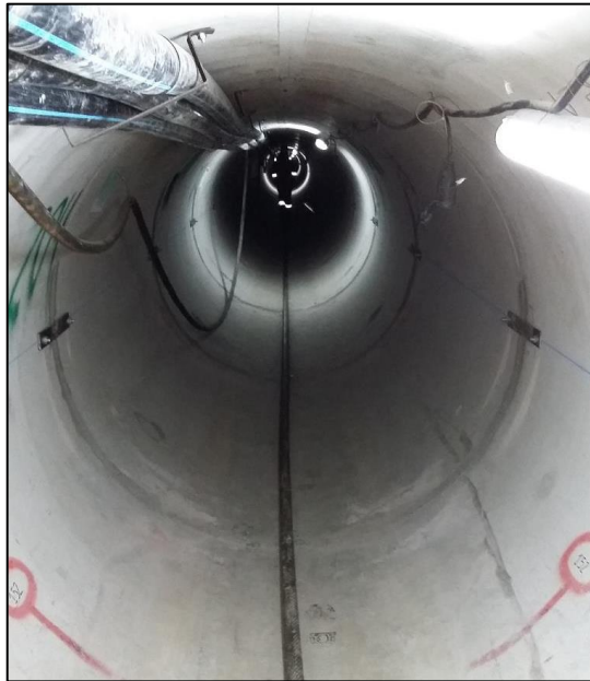
Figura 2.27: Tunnel pronto per l'inserimento della condotta. La fune d'acciaio collegata all'argano è stesa sul fondo del MT
