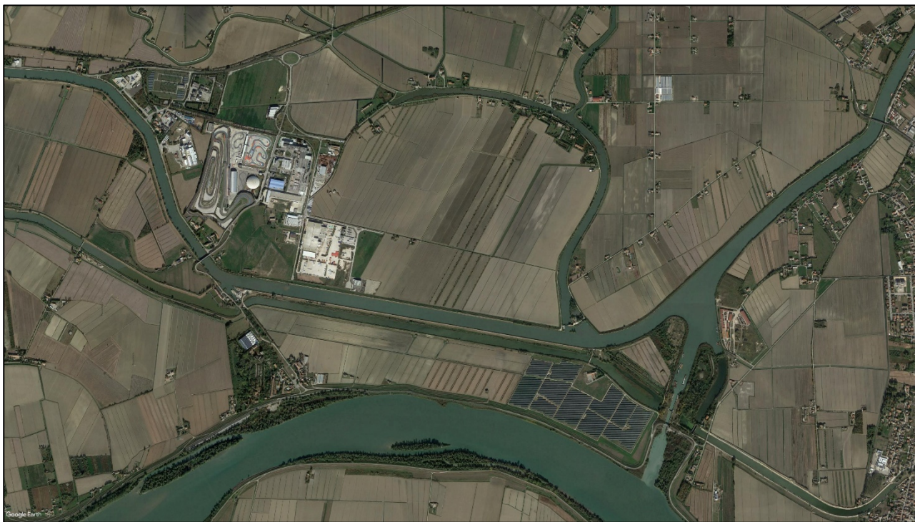
Immagine 6A - vista zenitale dell'area prima dell'intervento
