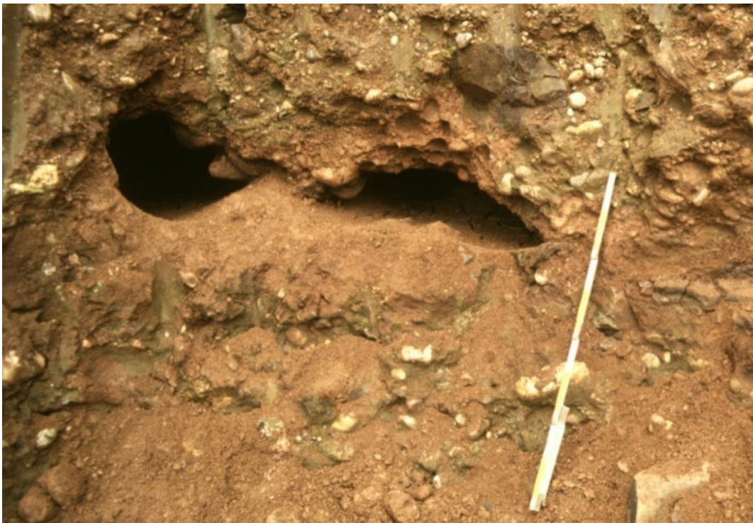
Foto 2-1 - Esempio di cavità in depositi non cementati
