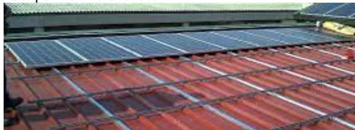
*Figura 4 struttura di supporto fotovoltaico compatibile con lamiera in alluminio*
