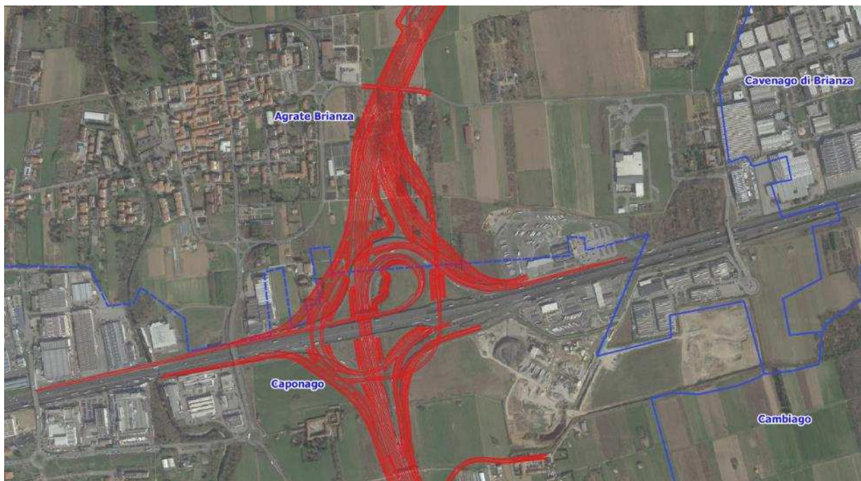
Figura 85 Tracciato in progetto dal raccordo con l'autostrada A4 nei comuni di Agrate Brianza e Caponago dal km 7+500 al Km 8+900, foto aerea del 2022 (fonte - Google satellite).
