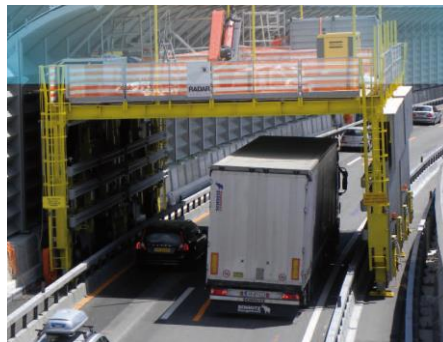
Figura 45 - Esempio di utilizzo di un cassero metallico di protezione
