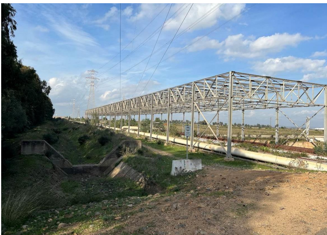
Figura 3.21 Vista del tratto che precede lo scavalco del fascio tubiero
