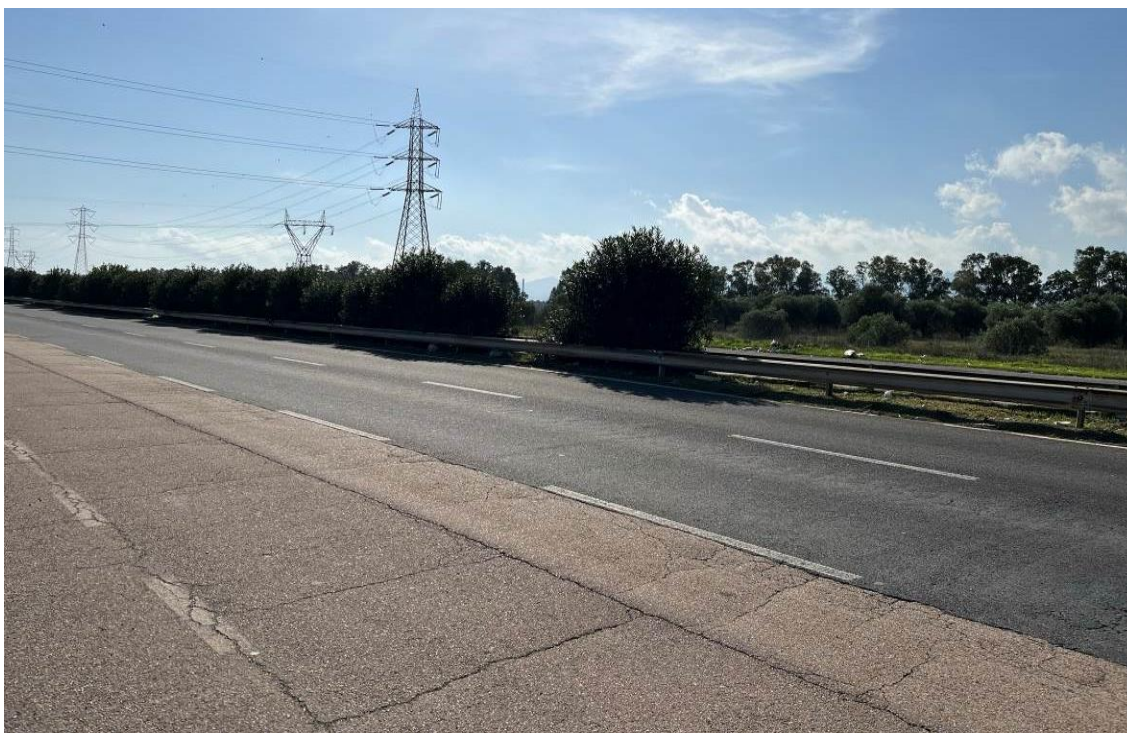
Figura 3.8L'infrastruttura attuale a inizio intervento
