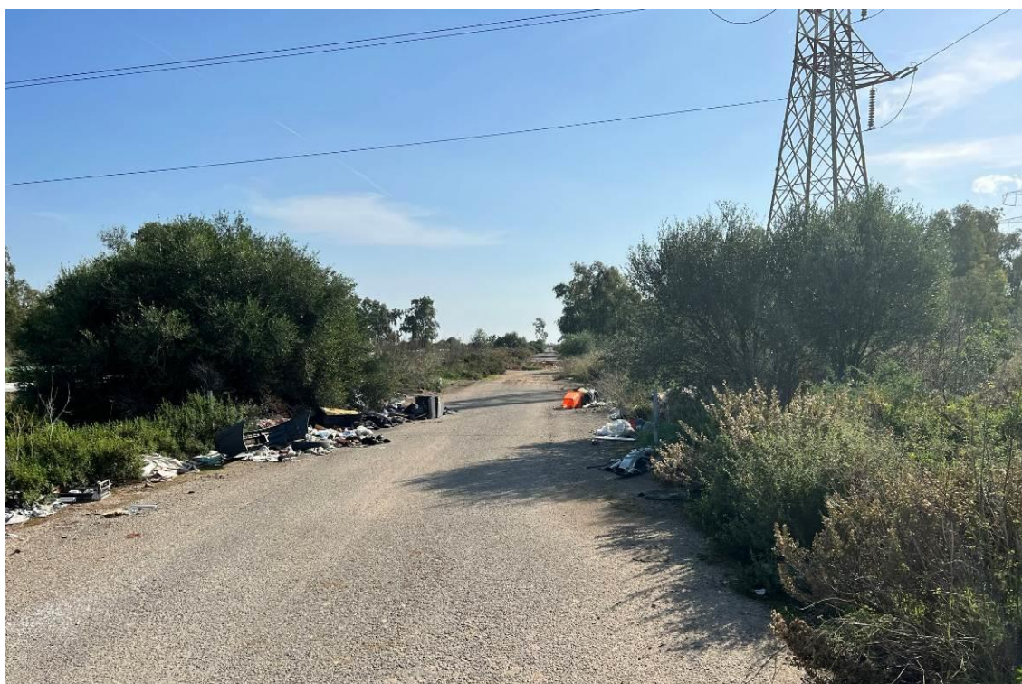
Figura 3.11 Fenomeni di degrado lungo la viabilità secondaria a servizio degli impianti
