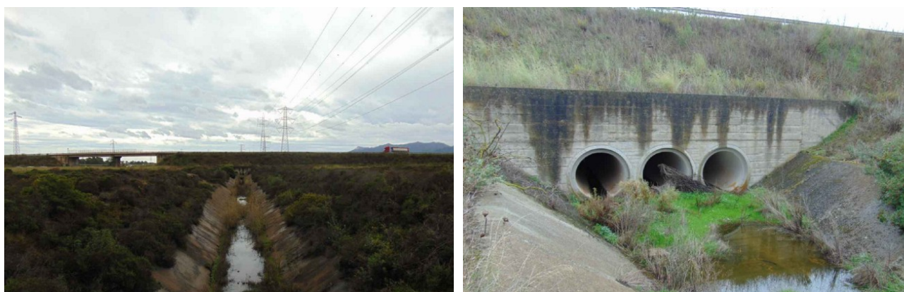
Figura 3 – Dettagli fotografici del canale Imboi e di un attraversamento
